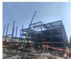
2024年10月2日施工进度
