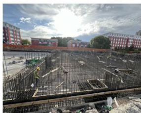
2024年9月14日施工进度
