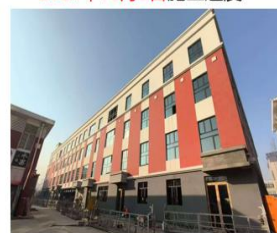
2024年11月14日施工进度
