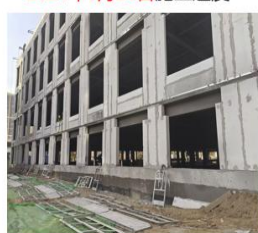
2024年10月23日施工进度
